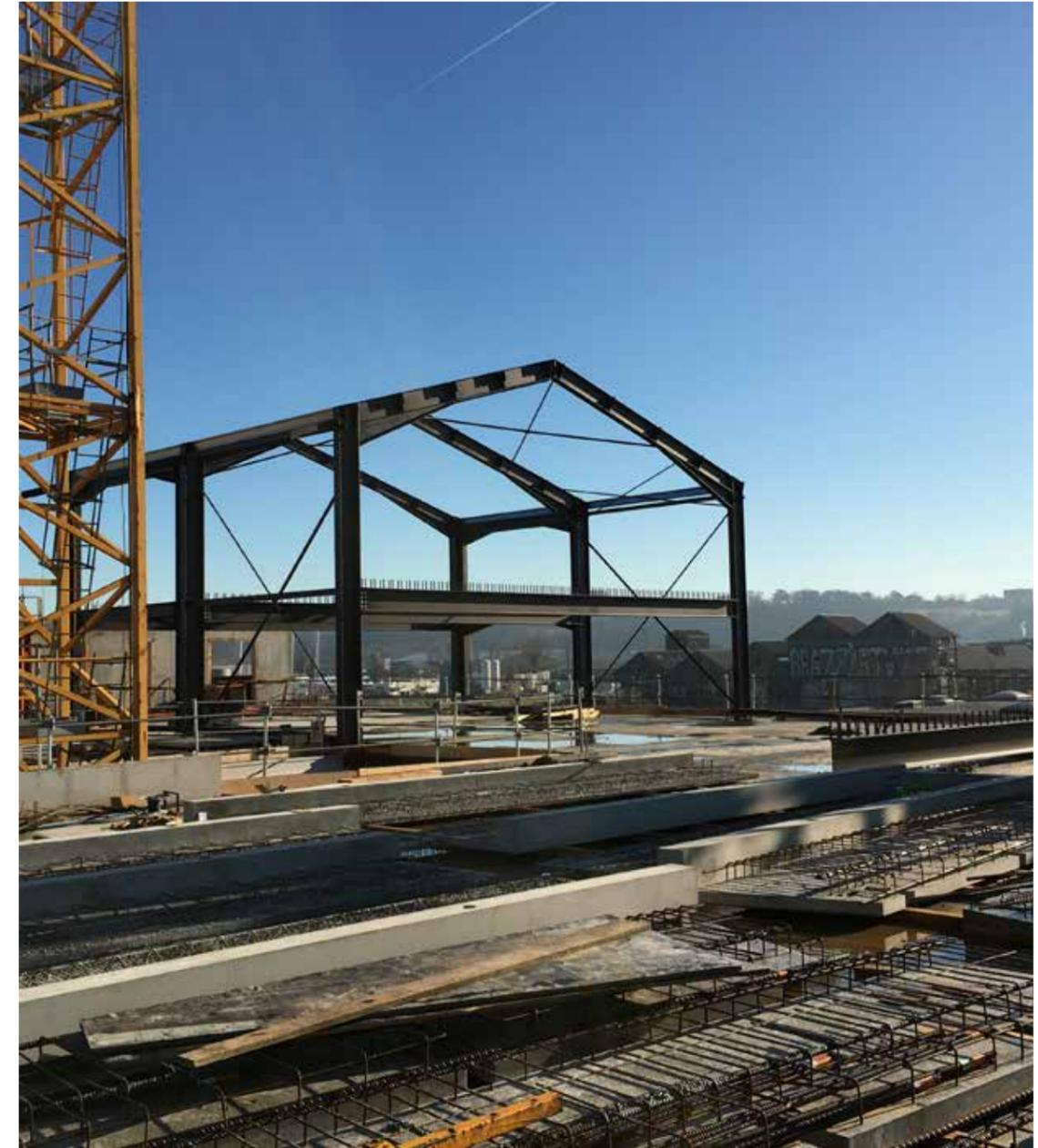
Sur trois niveaux de parking en poteaux poutres béton, les deux grandes halles de logements s'élèvent en une structure de portiques métalliques.
