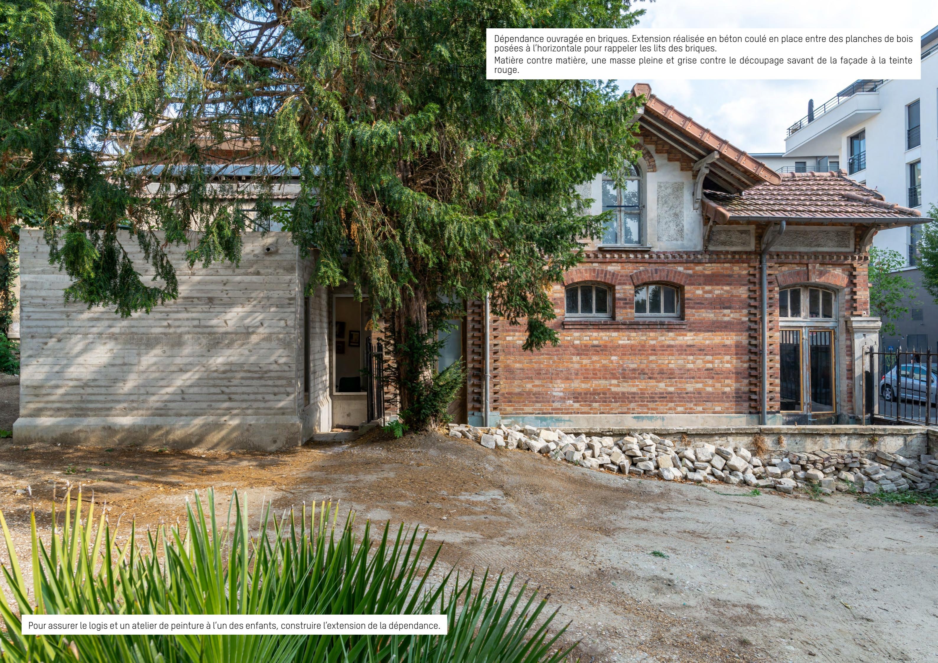
Dépendance ouvragee en briques. Extension réalisée en béton coulé en place entre des planches de bois posées à l'horizontale pour rappeler les lits des briques.
